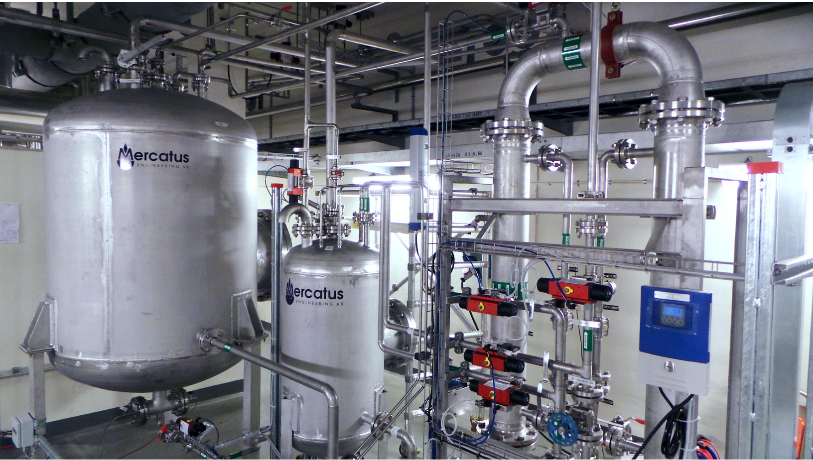
Anläggning som renar aktivt processvatten
