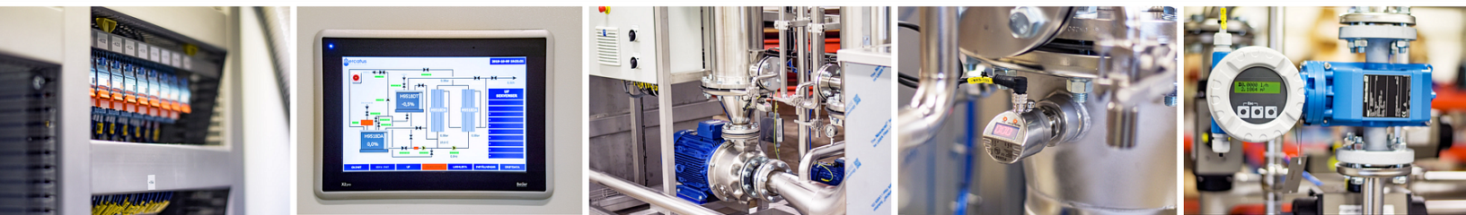
Keramisk ultrafilteranläggning för rening av oljehaltigt vatten.
